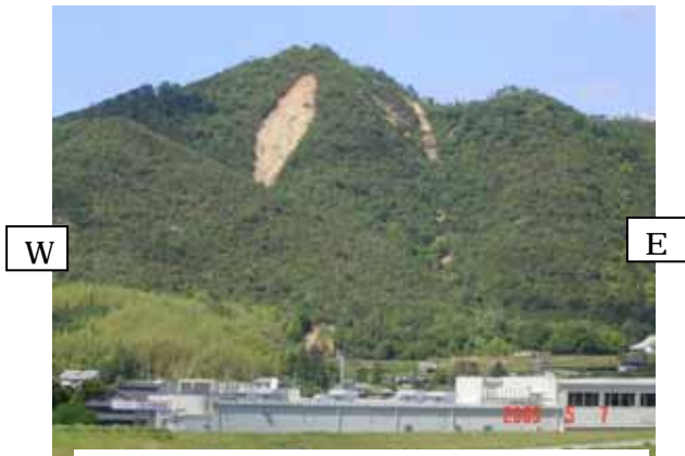
図 - 9 城山南斜面の崩壊
