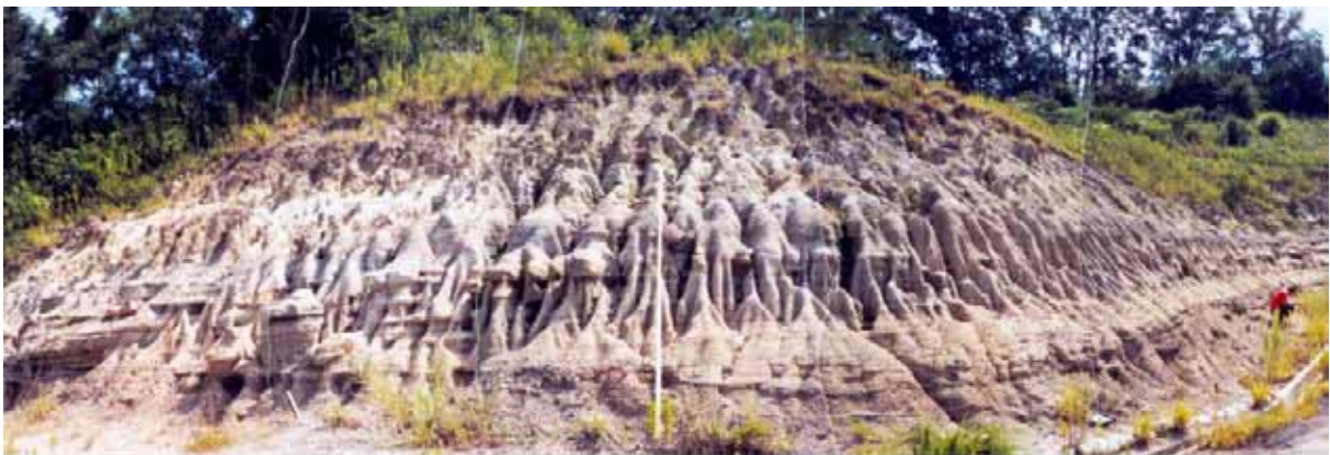
図1 神戸市日西原の切土法面の状況
