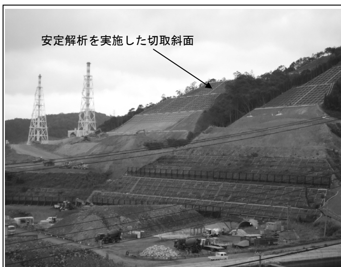
図-8 H17.10時点での切取斜面の状況
