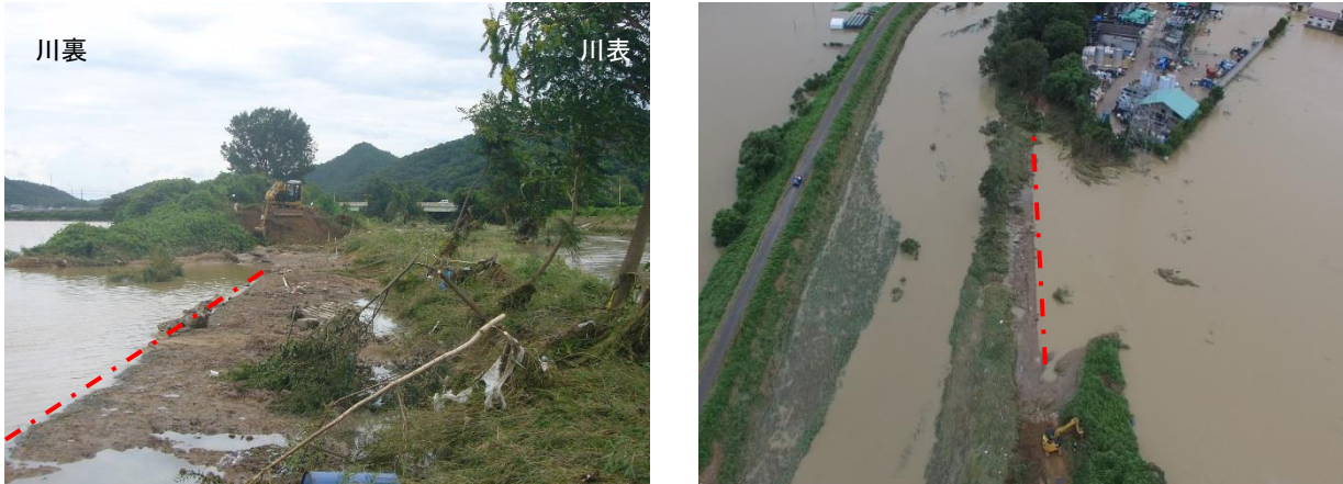
図-4. 破堤箇所被災直後の状況
