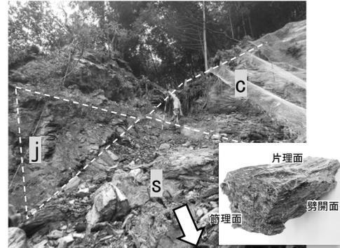
写真 1 崩壊形態を規制する弱面
