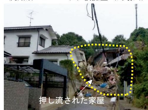
写真-4 土石流により押し流された家屋（地点 6）（神長川）
