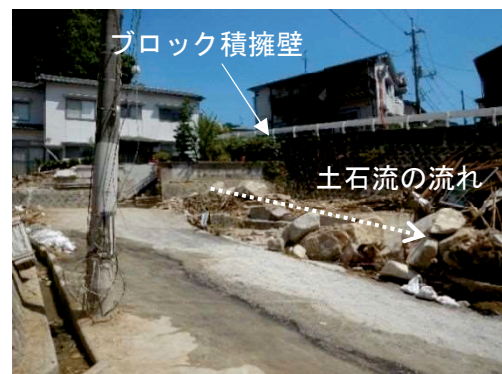
写真-3 地点 2 における土石流の流路沿いのブロック積擁壁（的場川）
