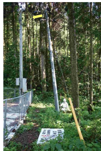
電柱の傾倒
