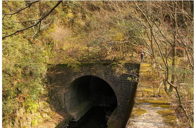
写真-1 鮎苦谷川の流れを飲み込む人工導水トンネル 右側には河川を塞いだ擁壁がみえる。
