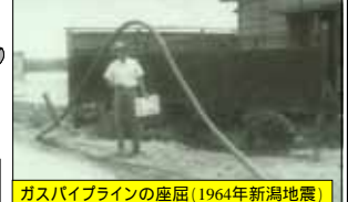
ガスパイプラインの座屈(1964年新潟地震)
