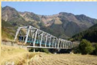
新設された橋梁
