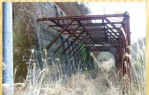
ロックシェッド(洞門)跡
