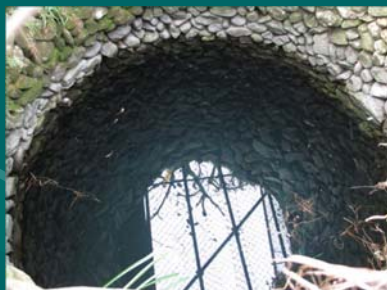
井戸内部状況 (観音寺市柞田町)
