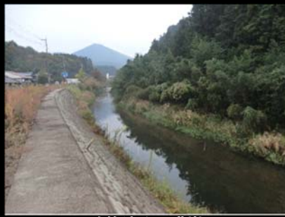
改修済みの護岸
