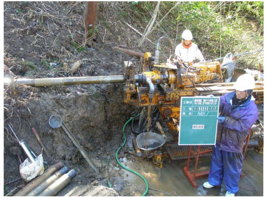
近年の横ボーリング状況(ロータリーパーカッション)
