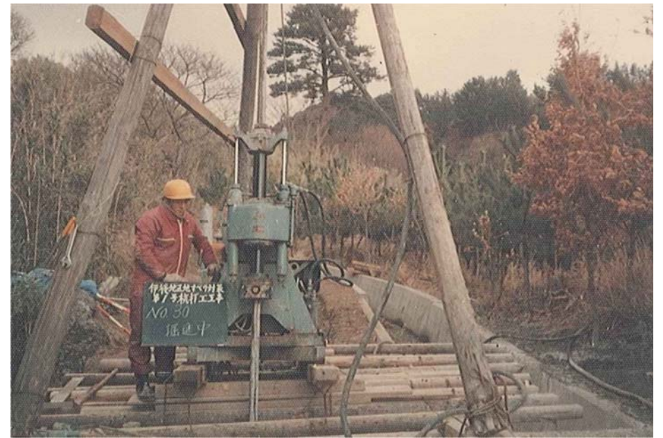
昭和54年杭施工状況
