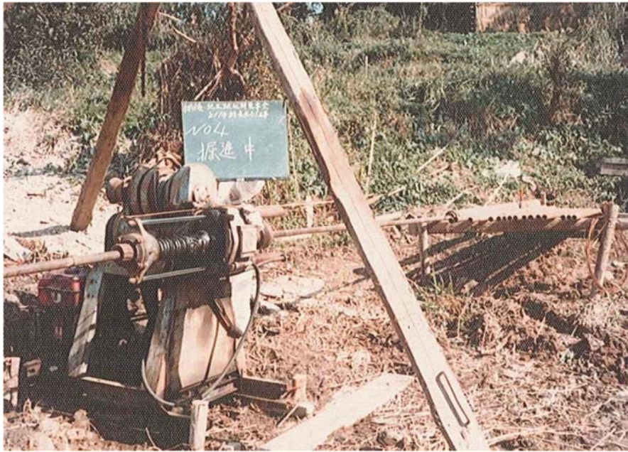
昭和54年横ボーリング状況(ロータリーボーリングマシン)
