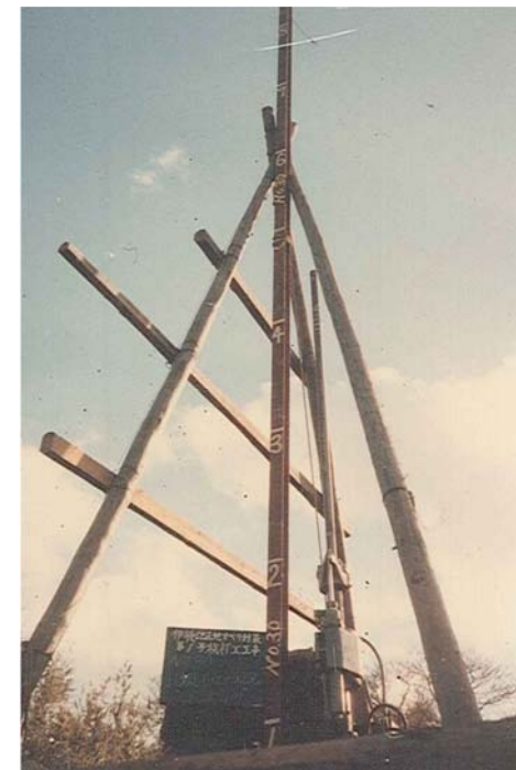
昭和54年杭立て込み
