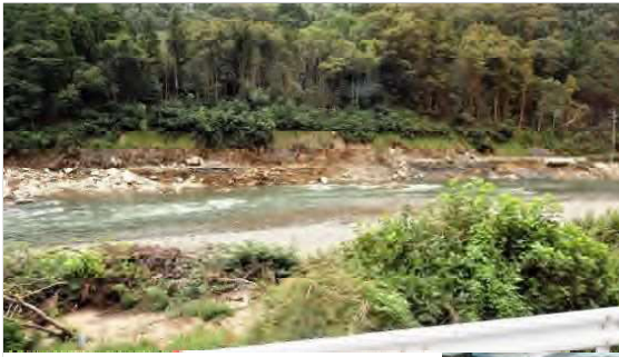
道路の流失や浸水
