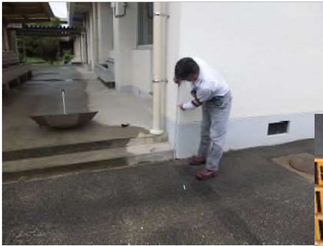
平島小学校での浸水水位 微高地に立地
