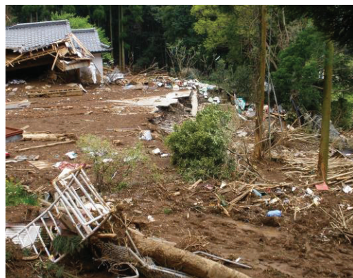
写真2 倒壊家屋と樹木。上流は左側
