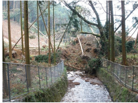
写真4 崩壊土砂による水路の閉塞
