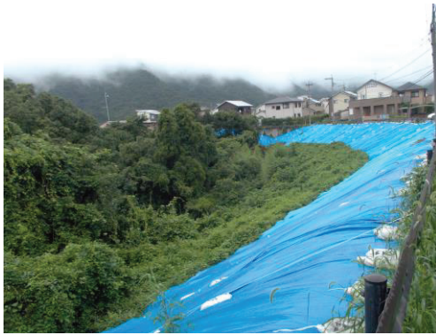
写真5 宇土市花園団地の盛土地すべり
