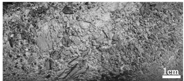
写真-6 BV2-1:28.6~28.7m 区間のコア状況
