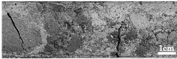
写真-1 BV2-2:44.05~44.15m 区間のコア状況
