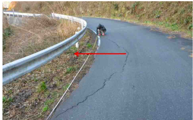
図-5 亀裂の方向 矢印は測定方向を示す。
