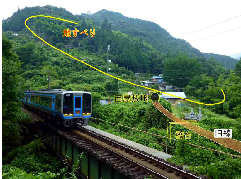
写真-2 起点側新旧分岐点付近 (A 地点) から眺めた西屋敷トンネル起点側坑口 (B 地点) 周辺の状況
