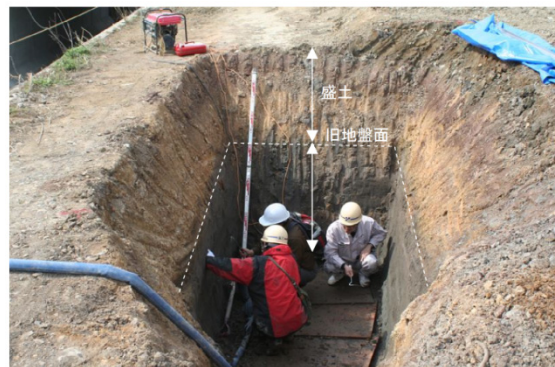
写真-3 掘削壁面の状況
