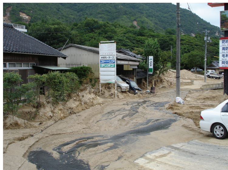
写真-5 国道 262 号付近の家屋被害 細粒の堆積物が家屋に流入している。
