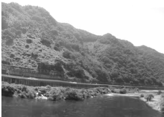
写真-1 花崗岩斜面の要対策箇所
