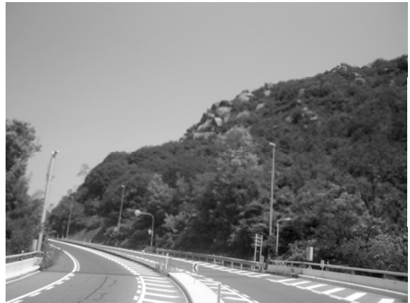
写真-2 風化残留玉石が分布する要対策箇所
