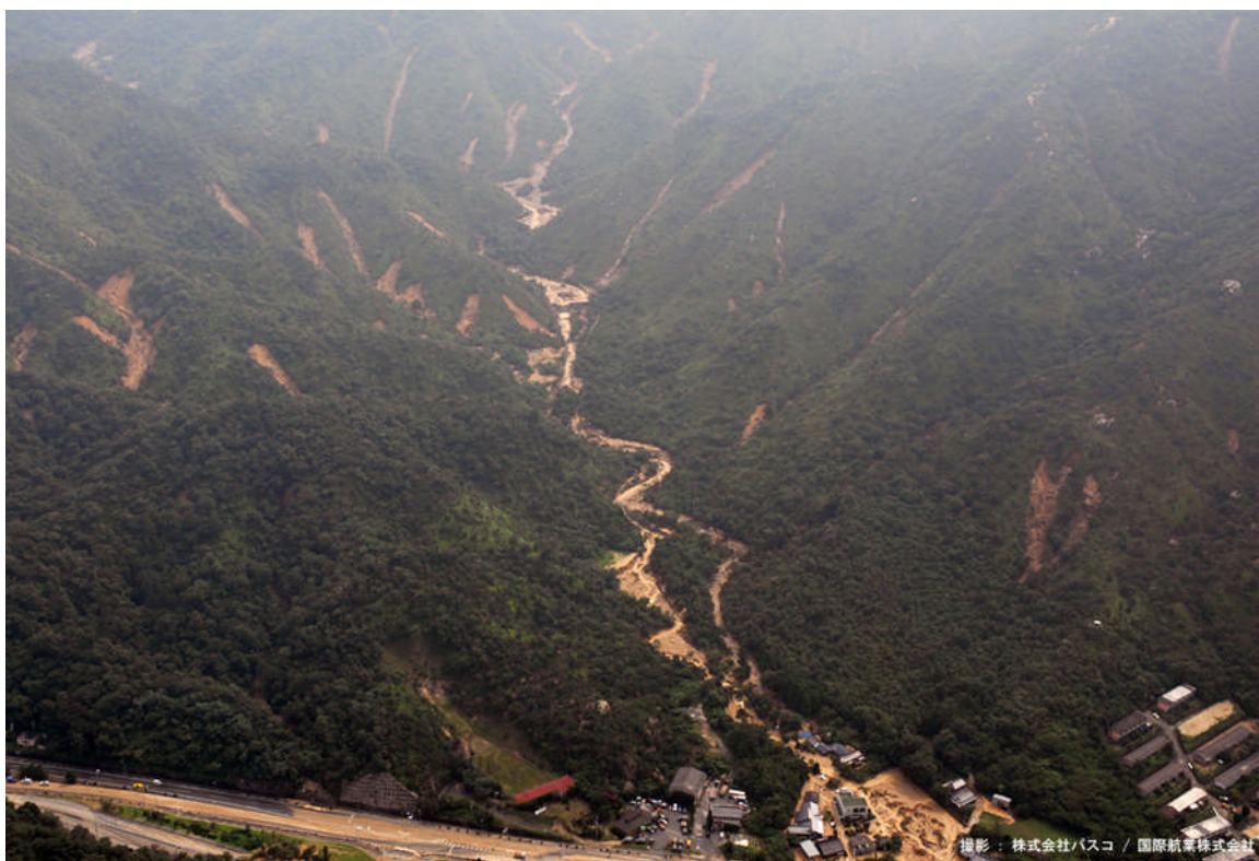
写真－3 災害直後の剣川の状況（谷頭や山腹斜面での崩壊が顕著）
