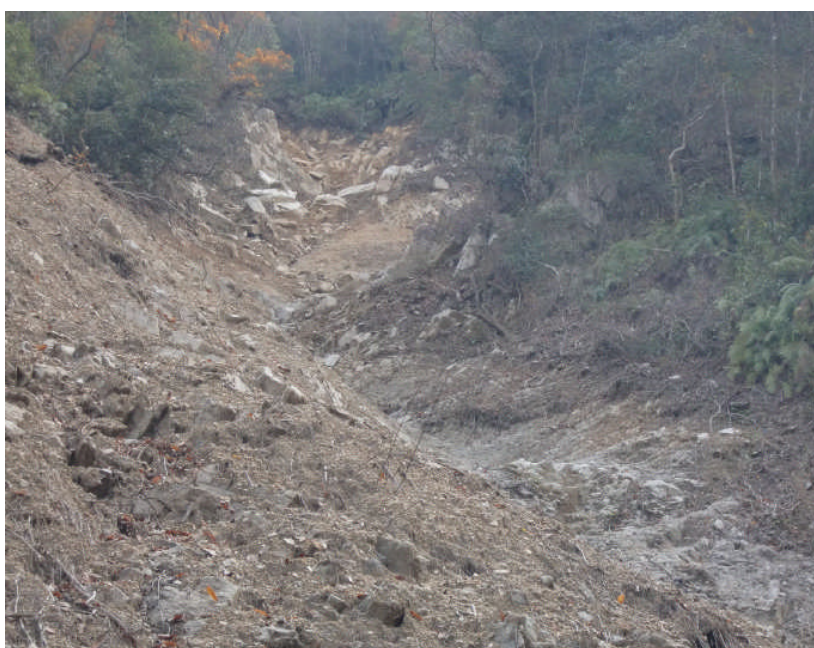
写真-11 石原 1 溪流源頭部の岩盤崩壊(土石流の原因)
