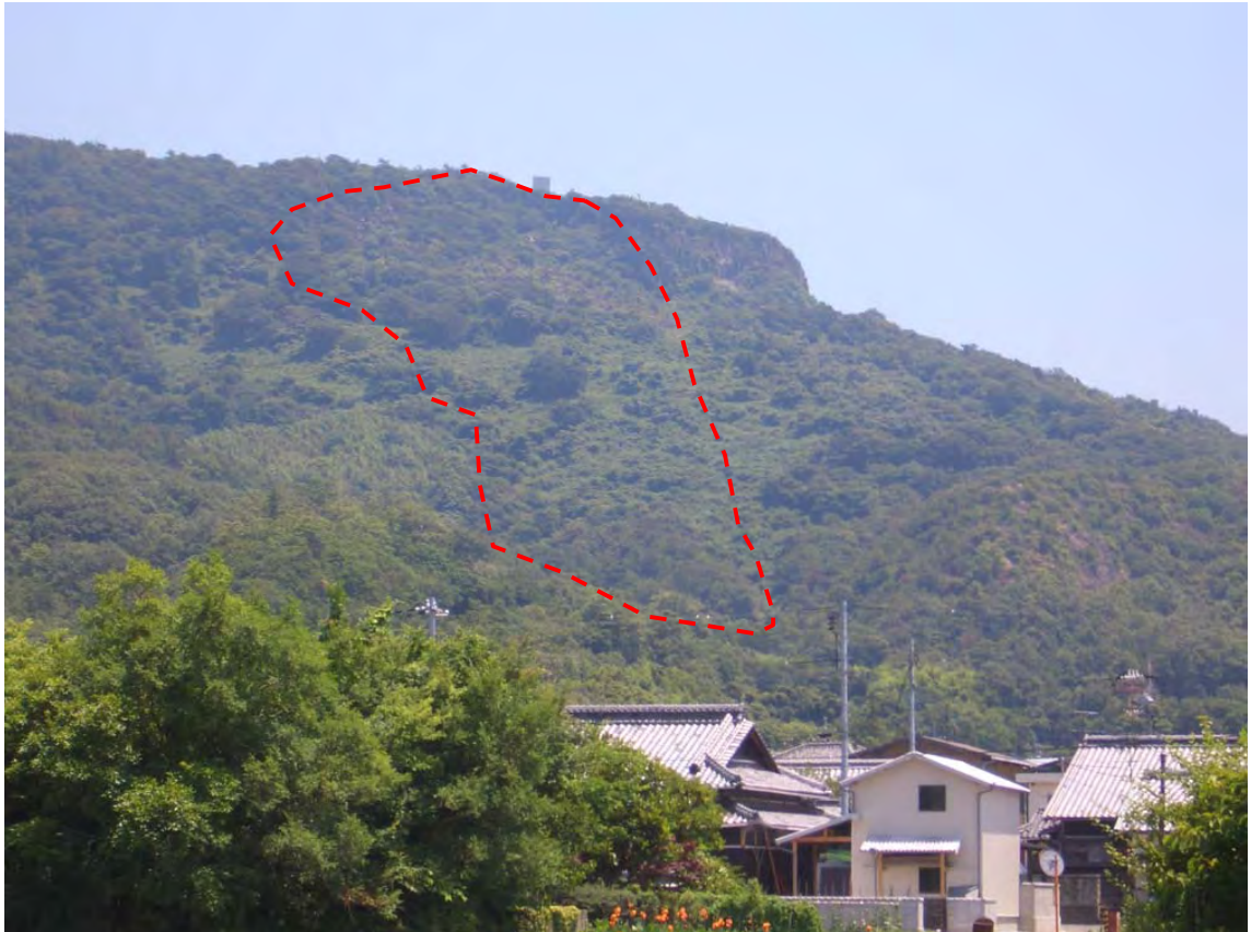
写真 5.3.1 春日川上流域のキャップロック地すべり全景
