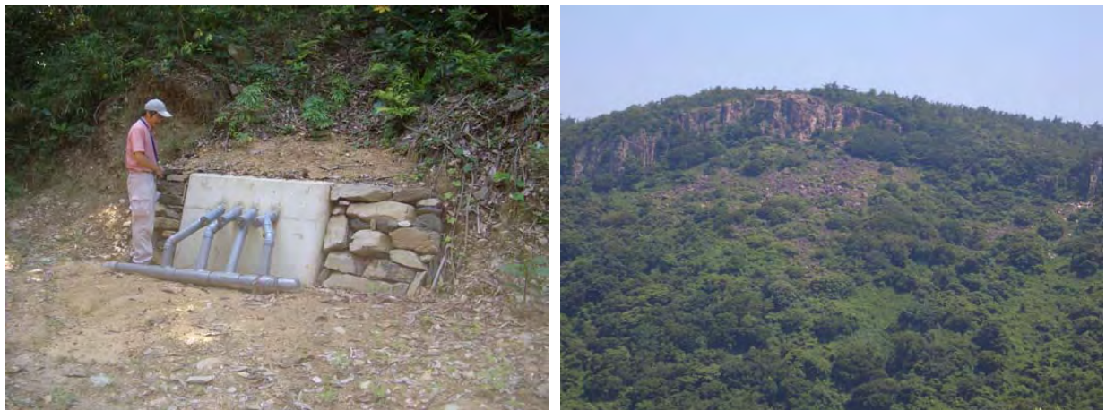
写真 5.3.2 左：春日川上流域のキャップロック地すべり地末端の排水ボーリング 右：地すべり地頭部のキャップロックを構成する安山岩の急崖， 地すべり地の南東方向から望む。
