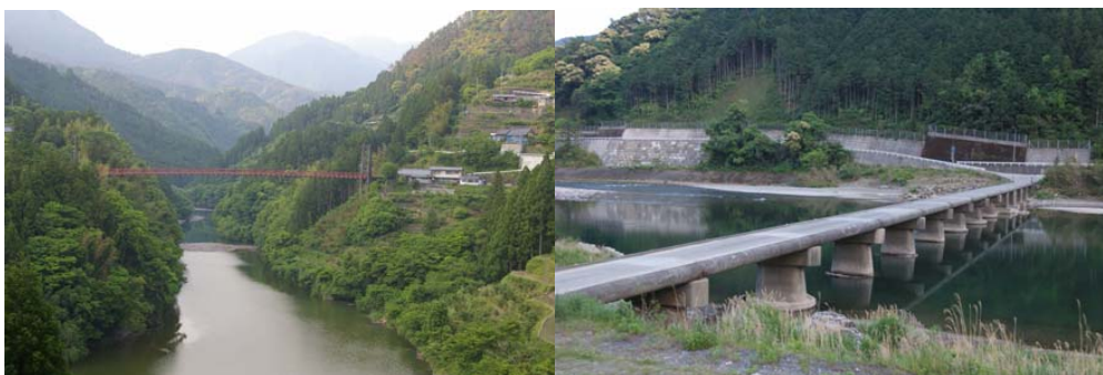
写真 - 5 渓谷との戦い - 橋を吊るか、橋を川に沈めるか（左：上葎生橋（物部川支流葎生川），右：越知町片岡（仁淀川））
