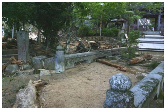
写真 16 土砂や石礫や流木を停止させた大聖院入口の橋梁のひとつ
