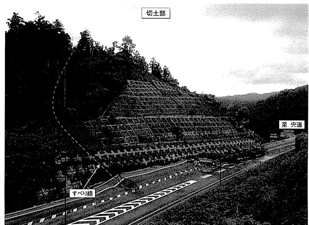
写真-1 被災状況写真
