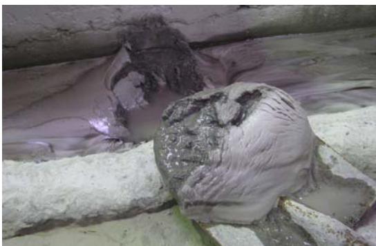
a. 排水路途中の沈殿物（石粉）
