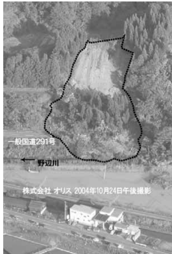
写真 - 1 横渡地すべり 101 全景
