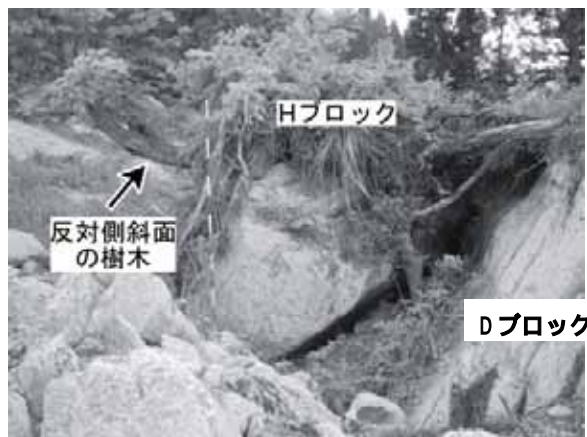
写真 - 2 Hブロックの様子
