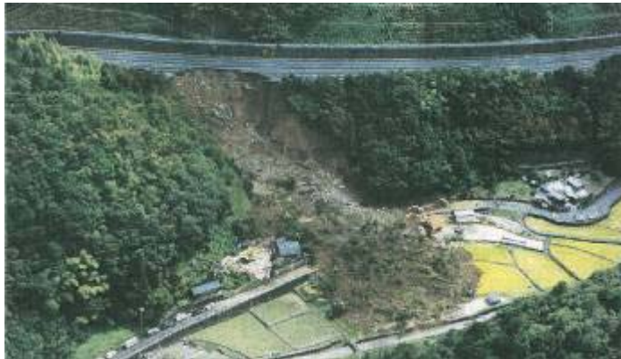
写真 - 1 山陽道甘木地区盛土崩壊写真（読売新聞 2005年9月8日より）
