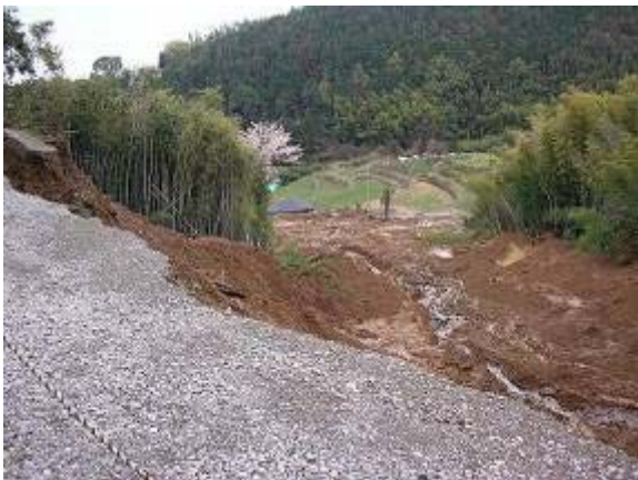
写真 - 1 山陽道甘木地区盛土崩壊写真（読売新聞 2005年9月8日より）
