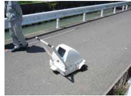
写真-2 地中レーダ探査状況
