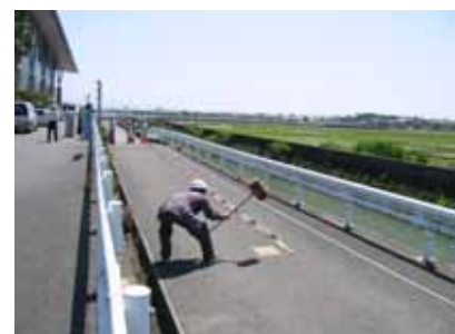
写真-1 表面波探査実施状況
