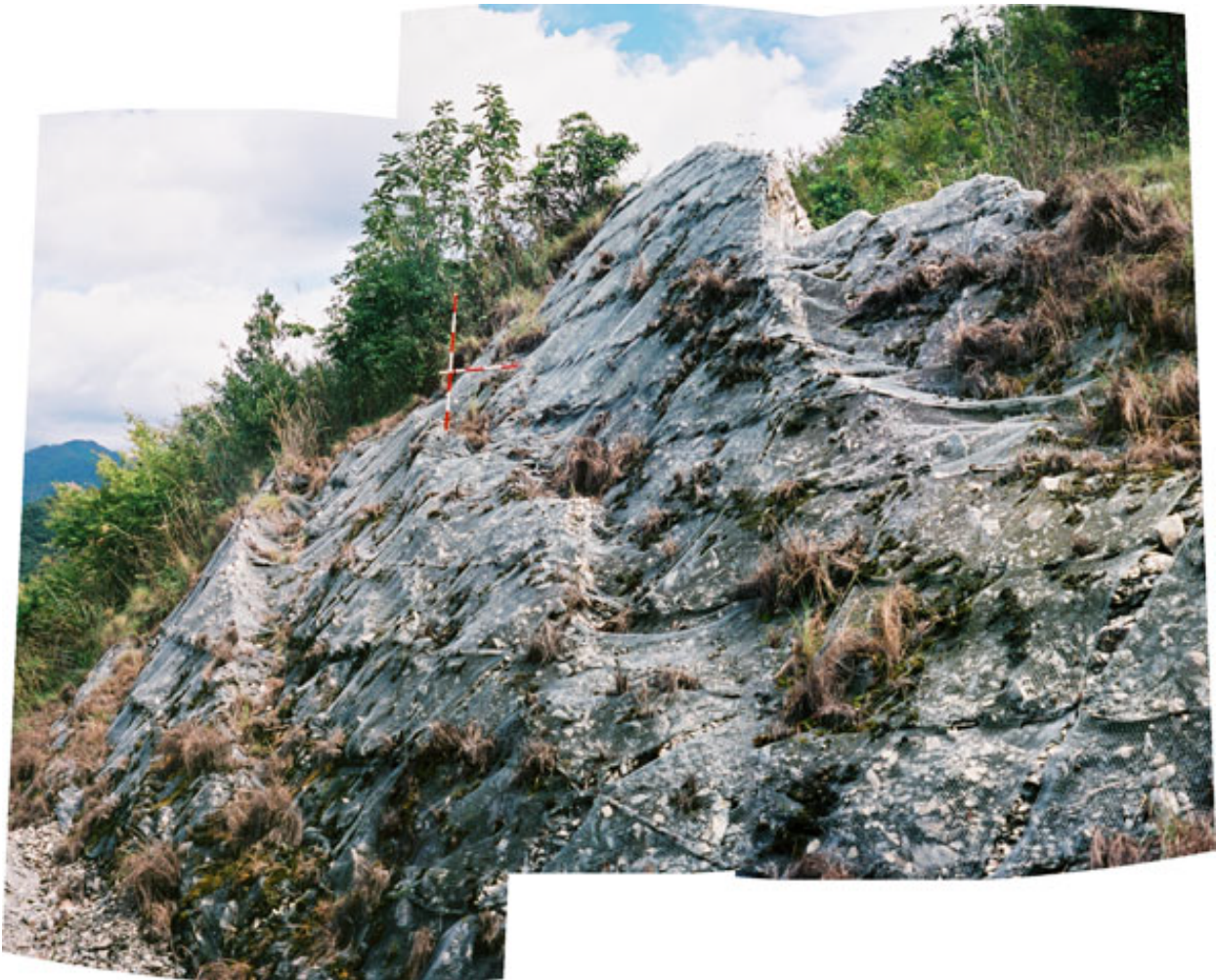
写真-2 調査地域（三段目切土斜面を西側から撮影）
