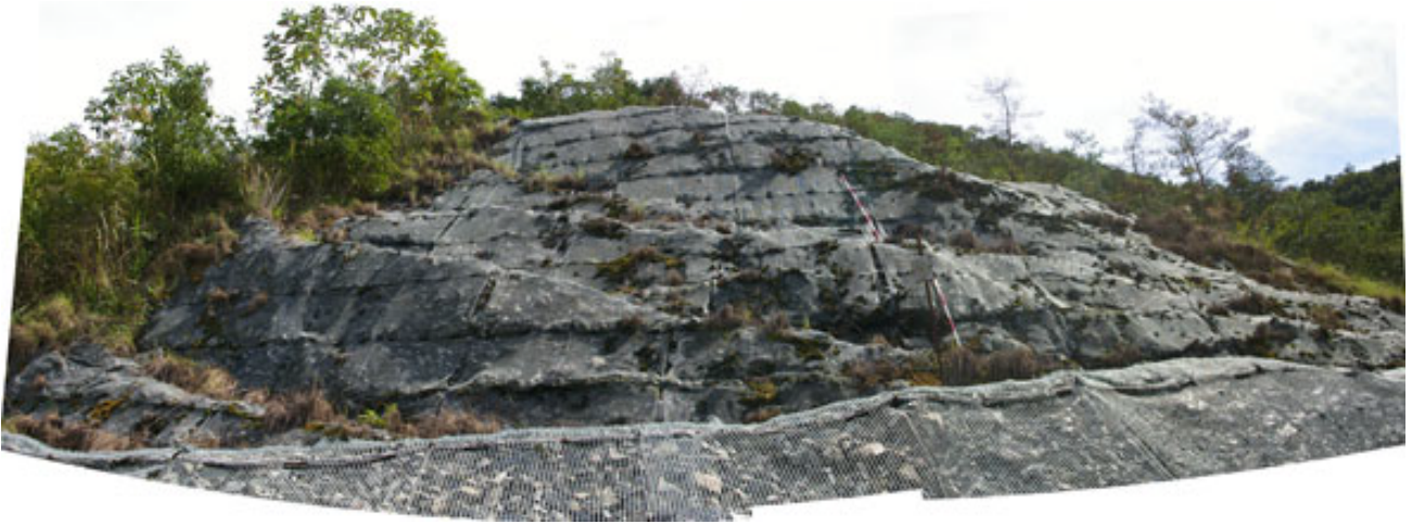
写真-1 調査地域（三段目切土斜面を正面から撮影）
