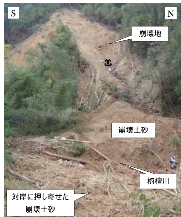
図-8 門入ダム上流の大規模崩壊 (さぬき市寒川町石田東門入)
