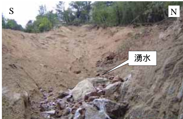
図-12 崩壊地から流出し続けている大量の湧水
