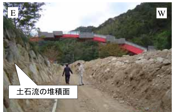
図-7 門入地区の土石流堆積物 (門入ブリッジ)
