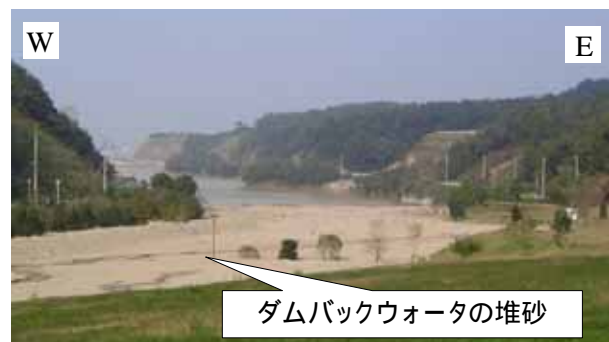
図-2 門入ダムに大量に堆積した土砂
