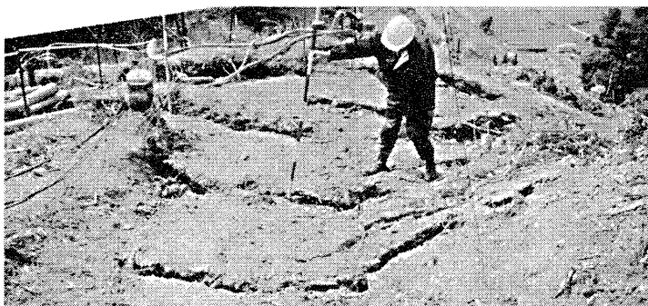
写真-1 無数に生じた開口クラック
