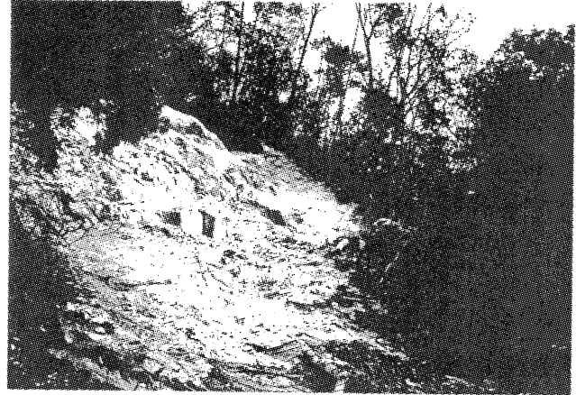
写真-2 芸予地震による斜面崩壊(河内町中河内)
