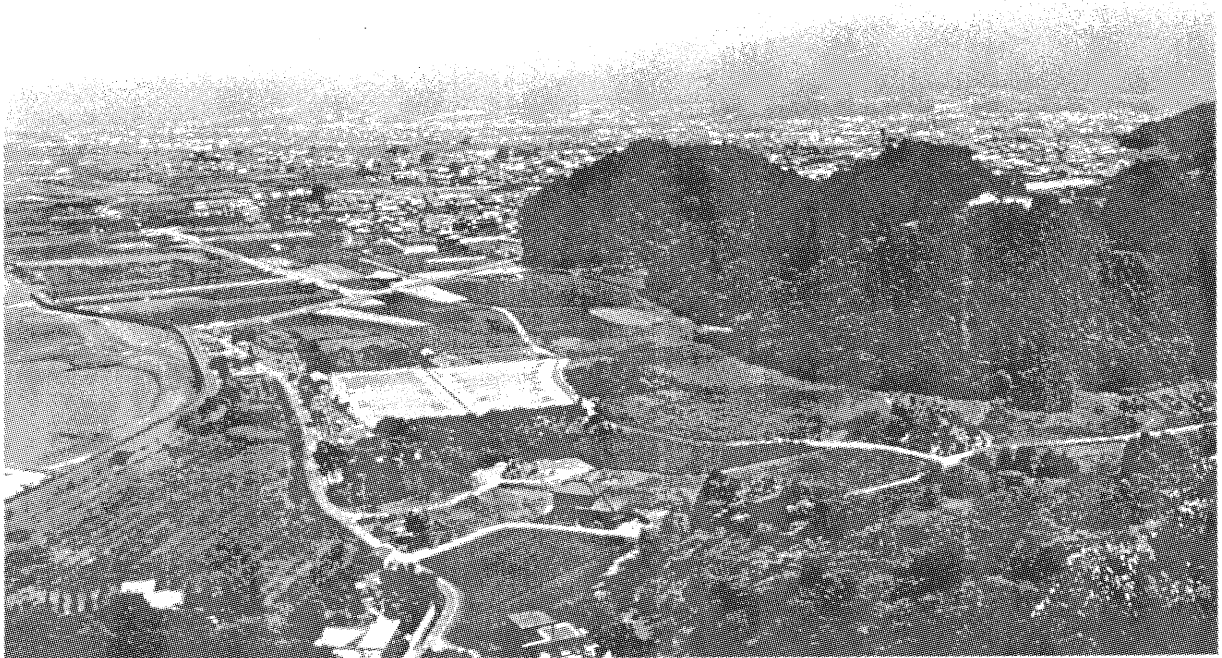
付図1 調査地の遠景 (土居町西之江より)
