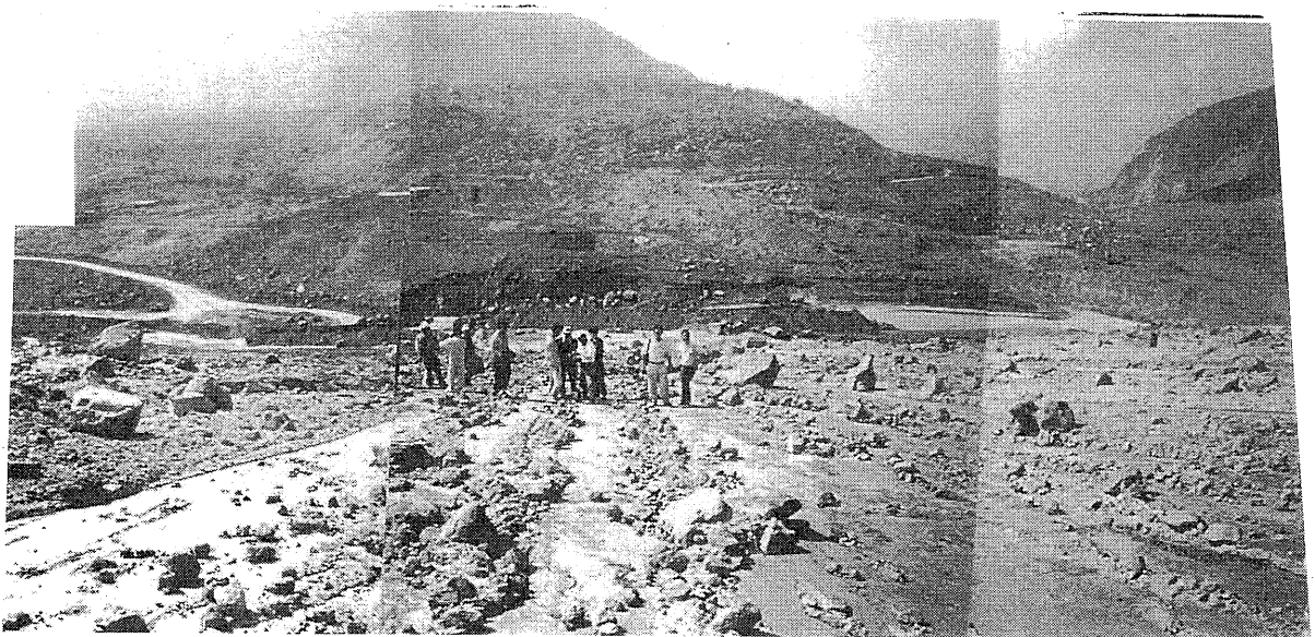
写真-5 中腹から見た草嶺大規模地すべりの末端状況
