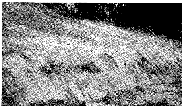
図7.37 地すべり発生前のり面状況 亜炭層上面の砂質土が地下水とともに流出。
