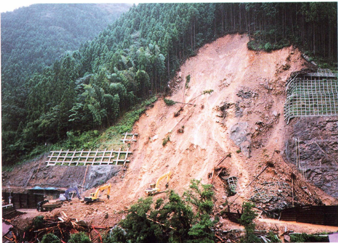
写真11 高知県道安田東洋線ののり面崩壊
