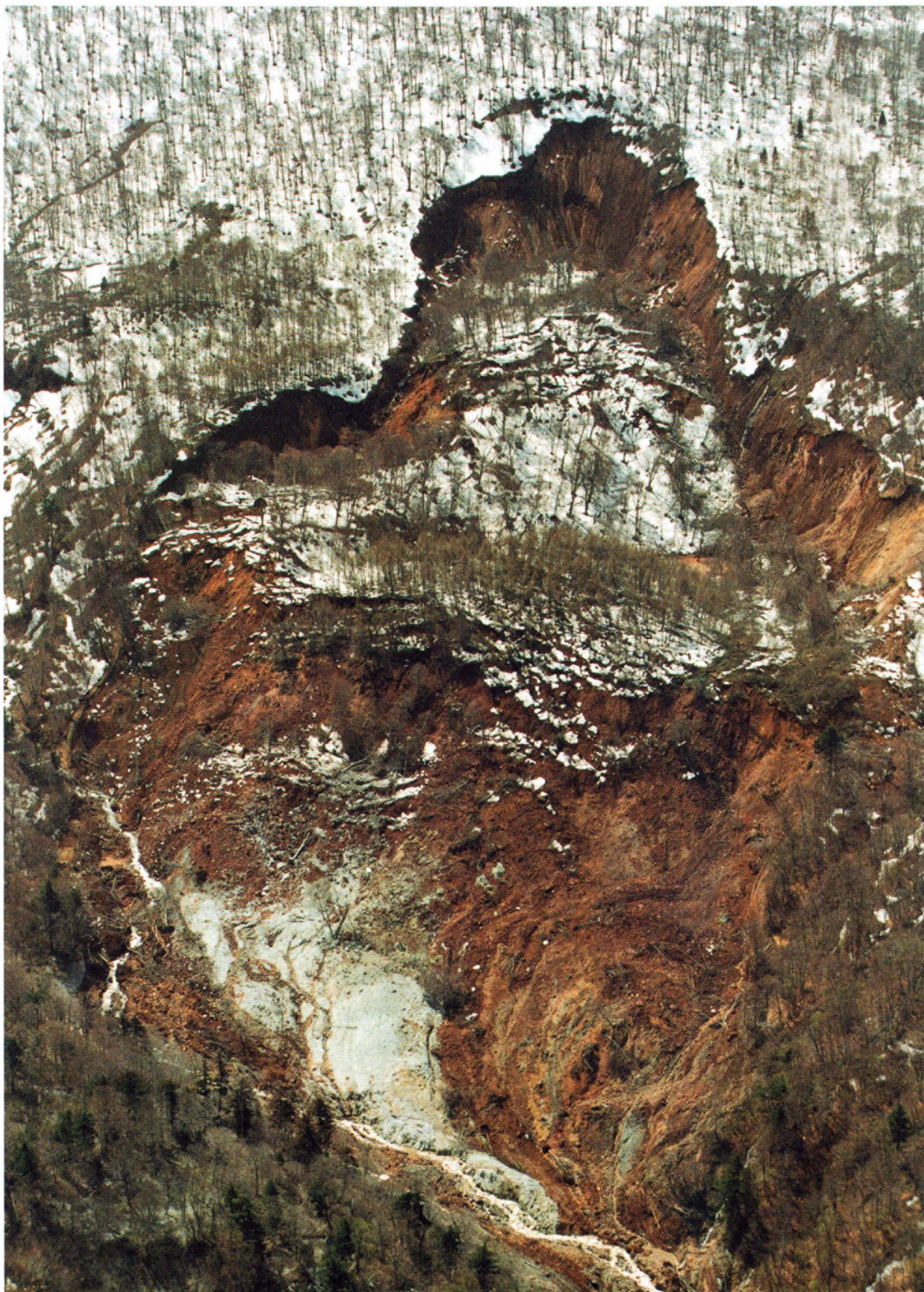
写真1 澄川地すべり
