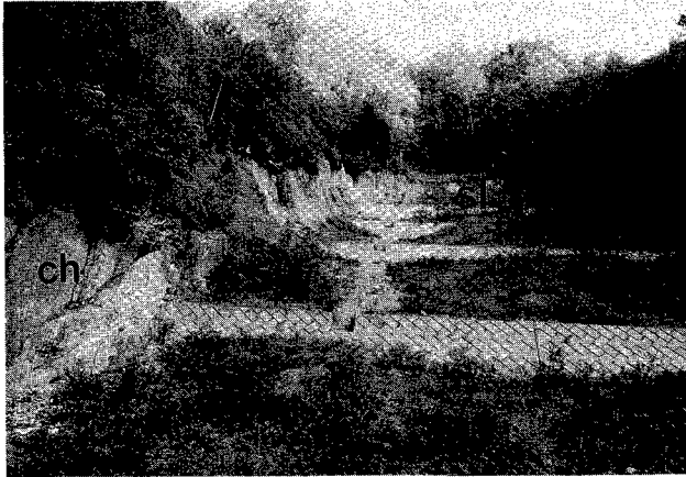
図2.1 層状チャート(ch)の層理面に側方崖を規制された崩壊(美濃帯、長野県)(横山俊治撮影) 移動体の大部分は泥質岩(粘板岩)(sl)で、チャートとの境界付近が左側壁にあり、層理面(複数)に沿って分離している。右側壁はほぼ断層に沿っている(写真には写っていない)。
