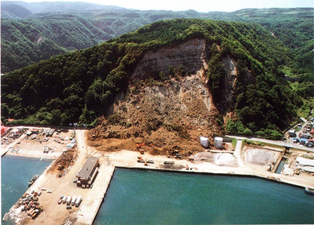
写真10 奥尻港地すべり
