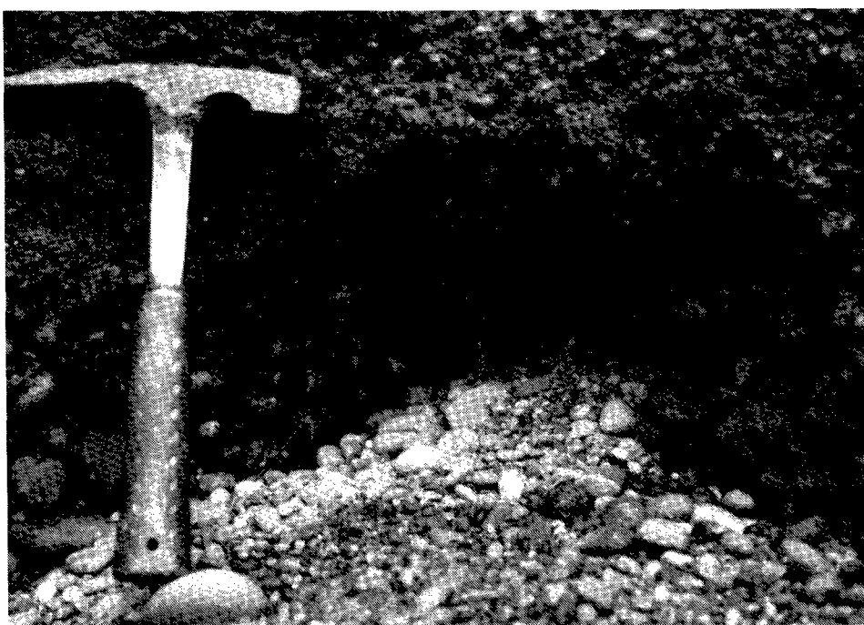
図 6.2.2 バイピングによって砂礫層中に生じた空洞と流出した砂礫。御前崎礫層。静岡県御前崎町。
