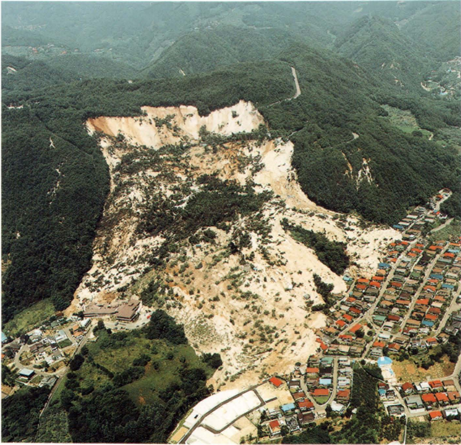
地すべり 地附山地すべり直後（1985年）の空中写真。 幅 250 m、長さ 500 m の大規模地すべりで典型的な市街地地すべりである。 （写真提供：アジア航測）
