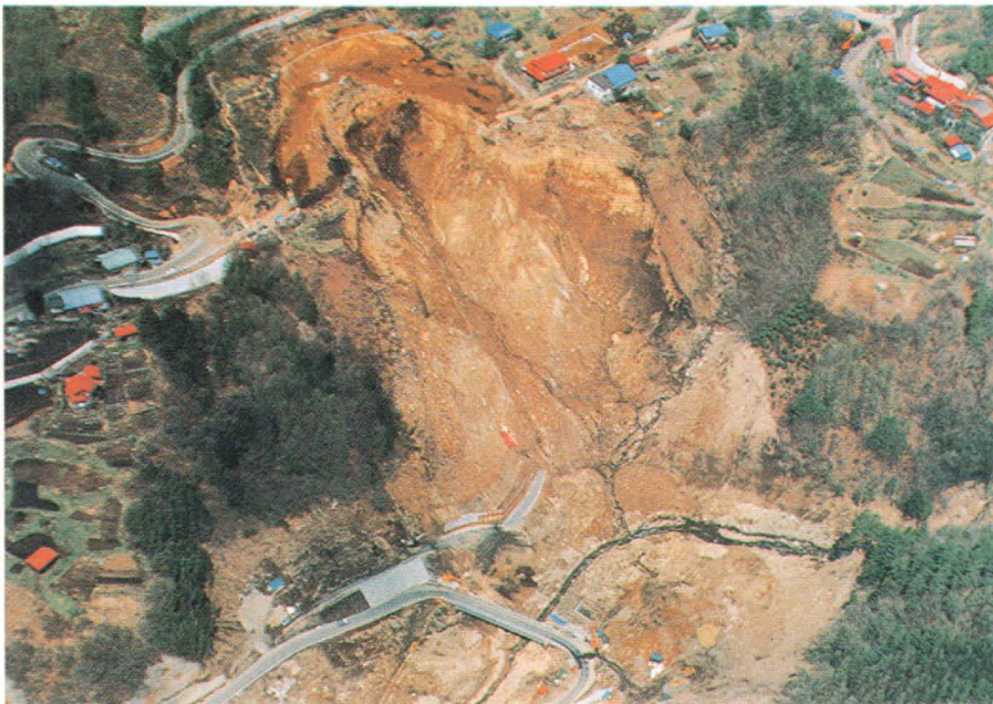
地震災害 1984年 長野県西部地震による斜面崩壊(県道御岳王滝黒沢線)。 (写真提供:長野県木曾建設事務所)
