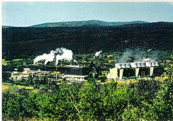
写真-2 オルカリア地熱発電所（遠景）
