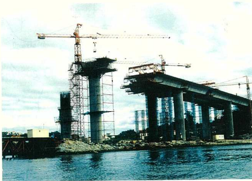
図-4 施工中の Freixo Bridge (Porto 市)
