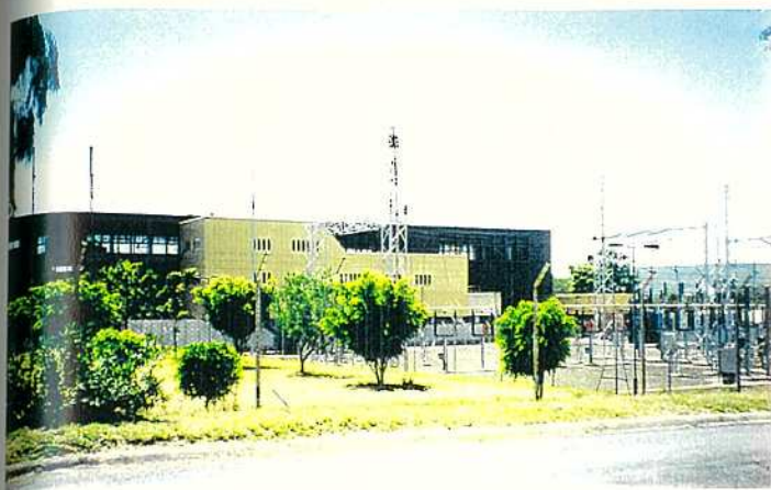
写真-1 オルカリア地熱発電所
