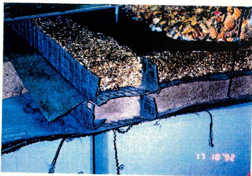
写真 4 - 4 マットレスの構造
