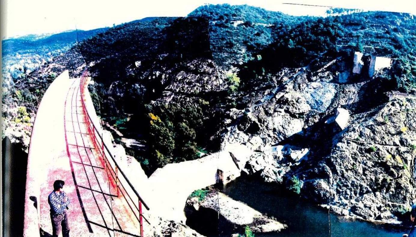
写真 6 - 2 右岸より左岸取付部を見る。 くさび状のすべり面が太陽に光っている。
