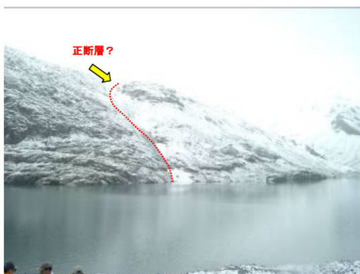
写真 4.14 貯水池対岸の断層露頭
