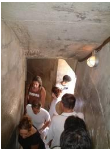
螺旋階段の状況
