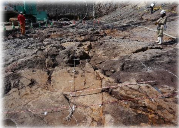
ダム基礎岩盤のスケッチ状況
