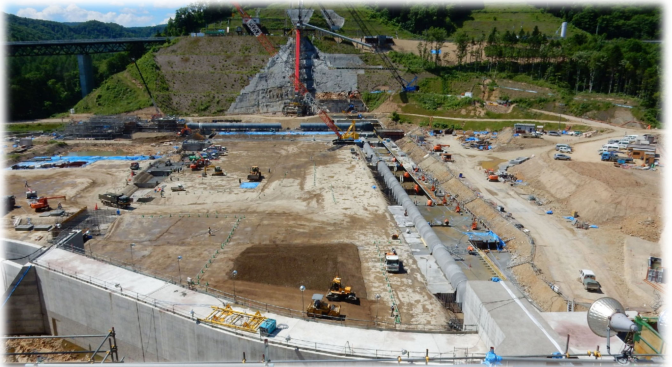
サンルダム(建設時の写真・ダム堤敷)
