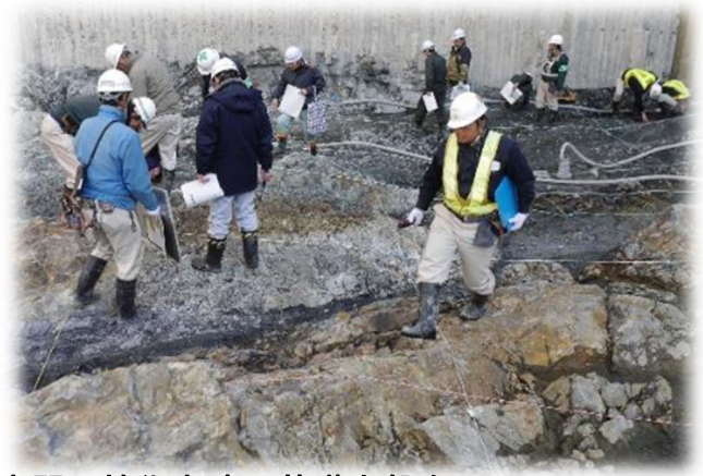
専門の技術者達で基礎岩盤をチェック！（岩盤検査）
