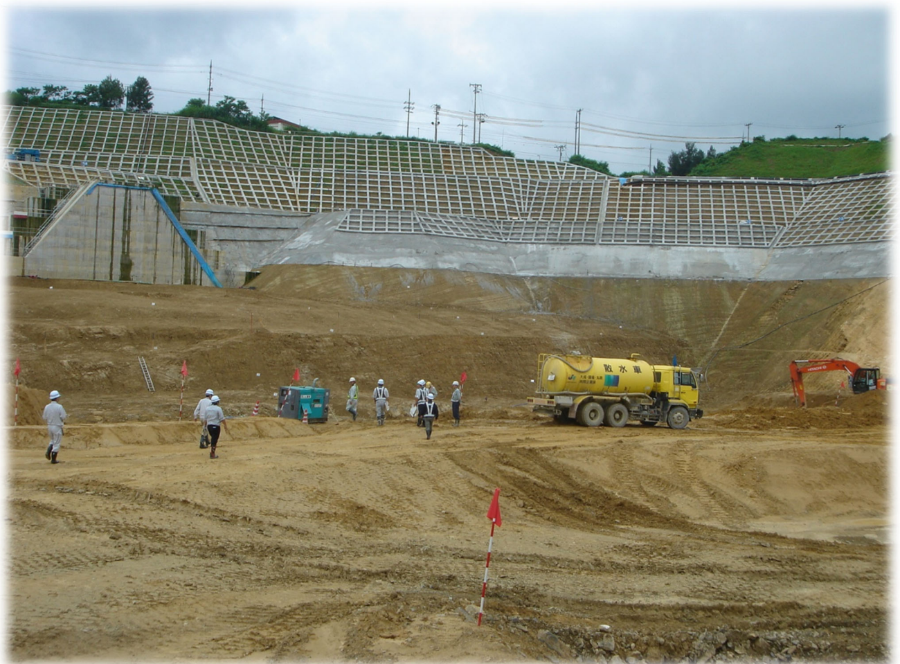
金武ダム(建設時の写真・右岸側)
