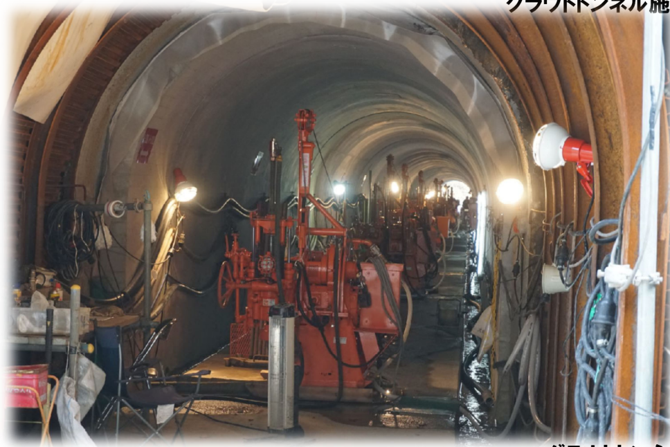
グラウトトンネル
