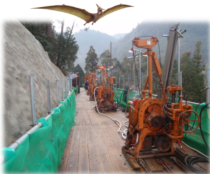
リム部(明かり)のカーテングラウチング施工状況 (大山ダム)
