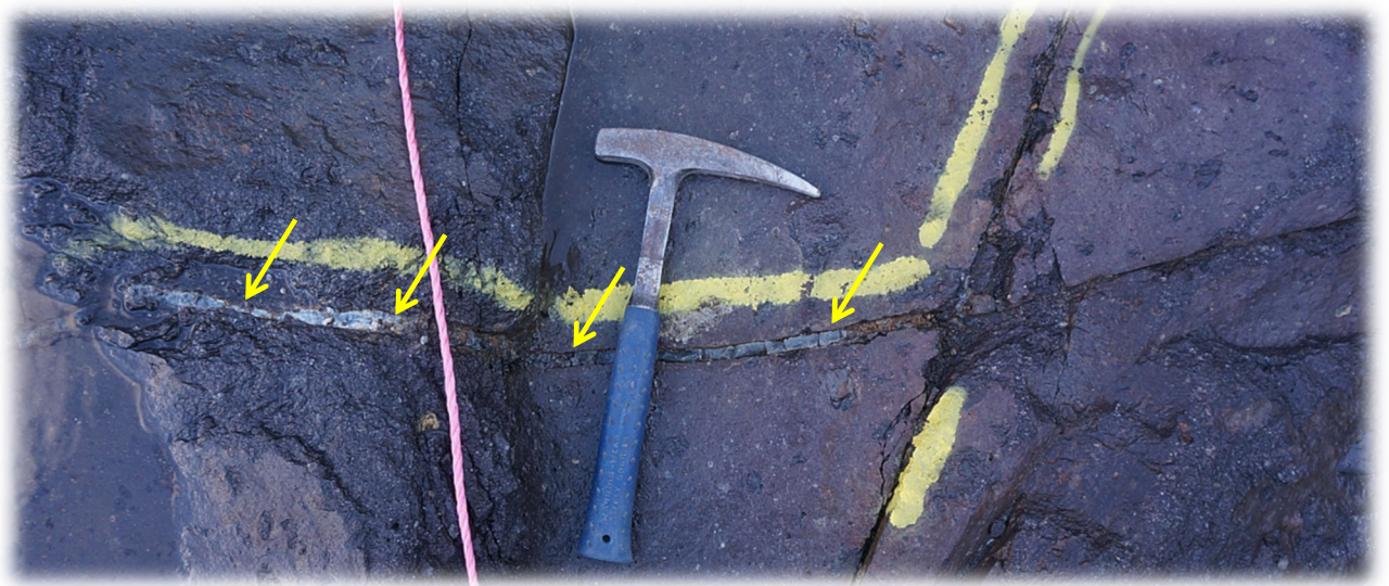
岩盤の割れ目にミルクが注入された様子
