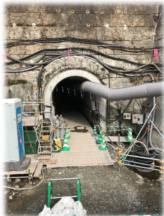
グラウトトンネル施工中 立野ダム
