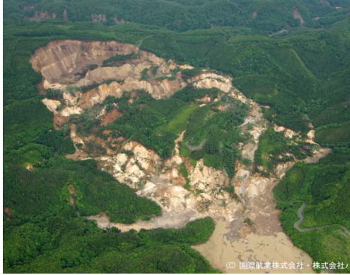
2008年「平成20年 岩手・宮城内陸地震」により発生した荒砥沢ダム上流部の巨大地すべり
