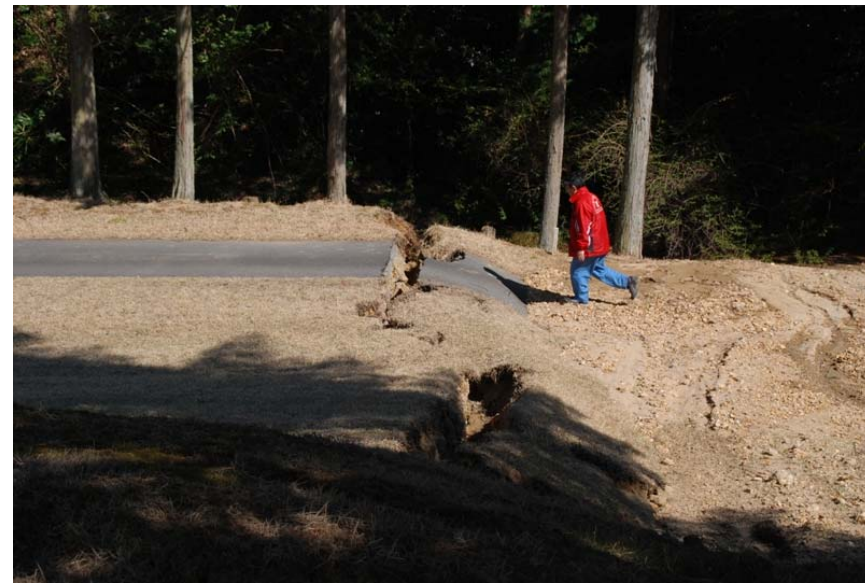
S60~65E方向を望む。撓曲状に変形する被覆層には開口亀裂が連続する。断層面付近に盛り上がりはない。
