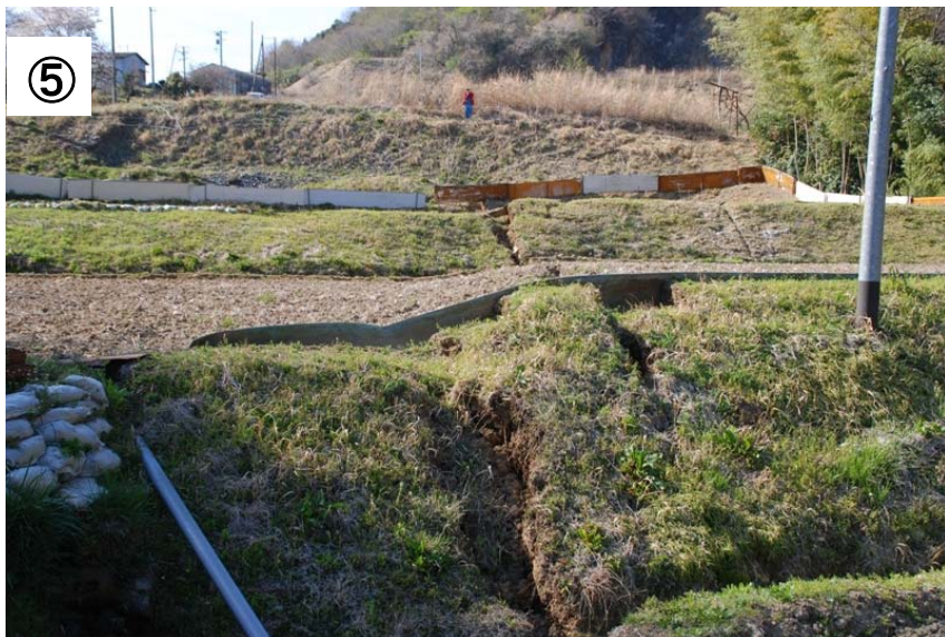
⑤ 湯ノ岳(右側)から続く山麓部。NW方向を望む。南西側落し50cm程度。耕作土に大きな開口亀裂が連続
