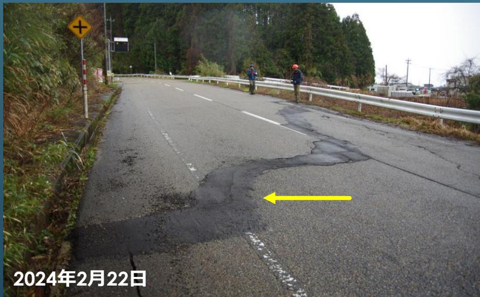
断層としての報告があったが盛土の沈下による舗装道路面の亀裂と判断される
