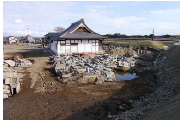
破堤地点堤内側の墓地と寺
