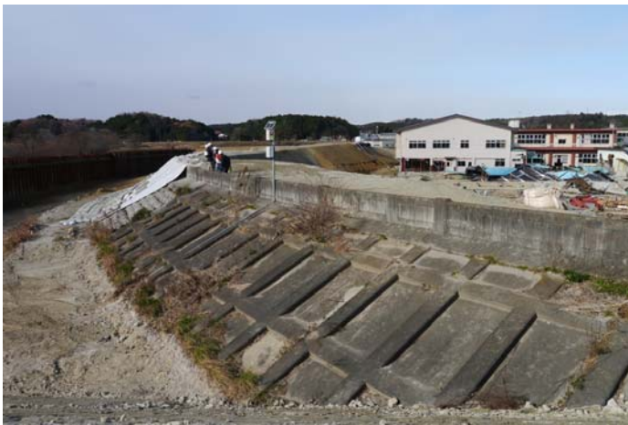
破堤地点における「特殊堤」(断面不足を補うパラペット)
