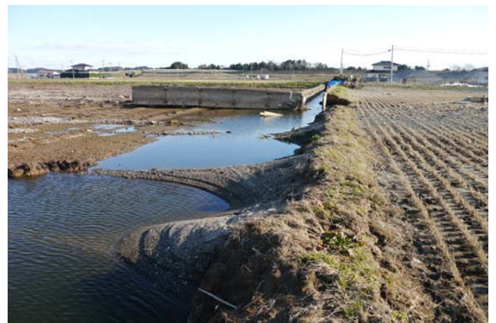
洪水流により掘り出された三面張り水路工
