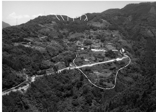
写真-1 地すべり末端が河床より高標高に位置する打木地すべり（高知県吾川郡いの町打木）
