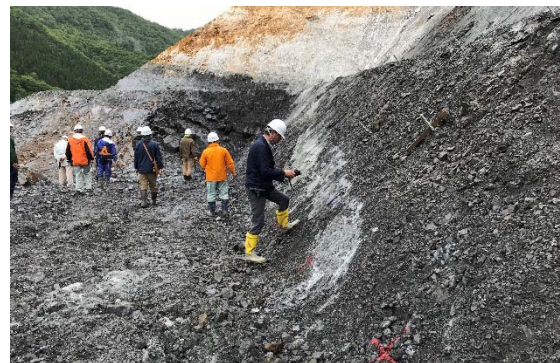
写真10 泥岩にシート状に挟在する粘土のような凝灰岩
