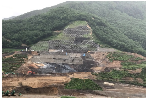
写真5 右岸掘削面の遠望
