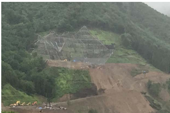
写真4 左岸掘削面の遠望
