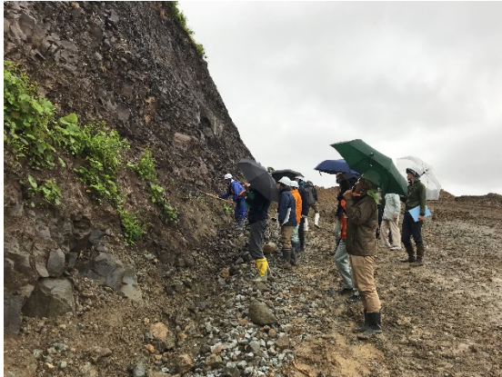
写真7 左岸工事用道路切土面の巡検 (西小沢層割れ目ゾーン底面付近)
