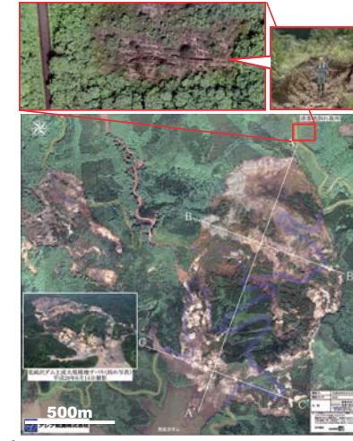
写真2 (下) 地すべり全体のオルソモザイクおよび測線位置図 (上) 高解像度航空デジタルカメラ(DMC)が捉えた亀裂と、その現地状況
