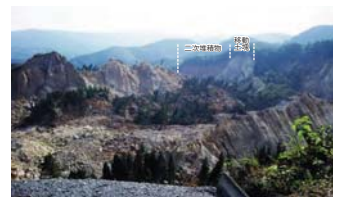
写真4 側方崖の様子
