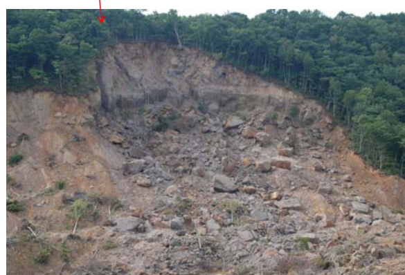
溶結凝灰岩の大規模崩落
